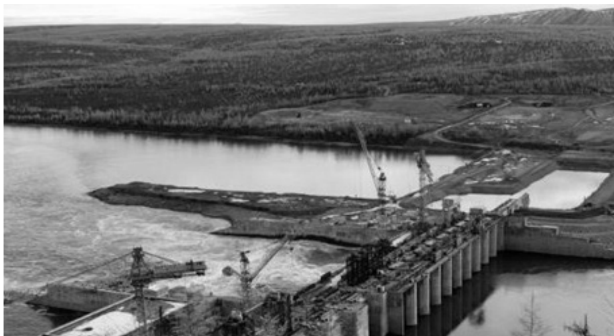
Плотина Усть-Среднеканской ГЭС.
