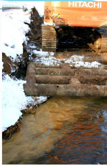
Ручей Симовый. 21.11.08. Строительство траншеи трубопровода, сопровождающееся сбросом сточных вод в ручей с образованием мощного шлейфа мутности
