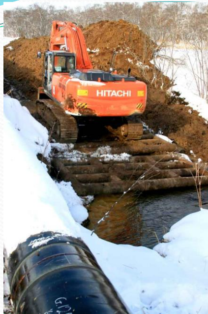
Ручей Симовый. 21.11.08. Строительство траншеи трубопровода, сопровождающееся сбросом сточных вод в ручей с образованием мощного шлейфа мутности
