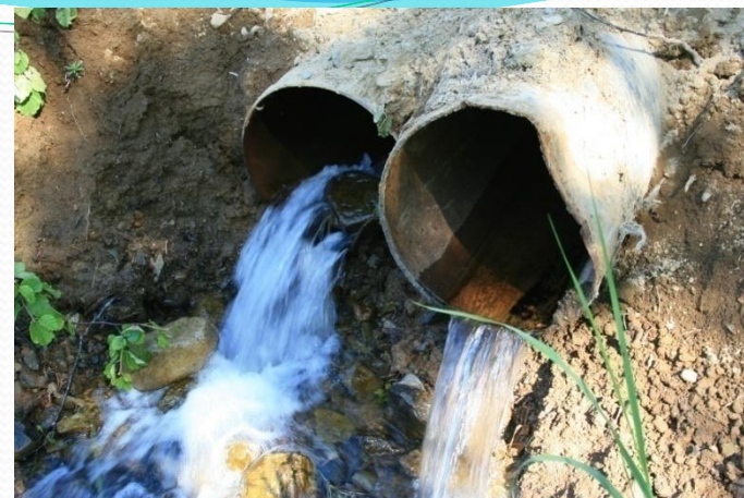
Ручей Б/н. 21.07.09. Непроектное искусственное сооружение нарушило не только гидрологический режим ручья, но и нарушило пути миграций лососевых рыб..
