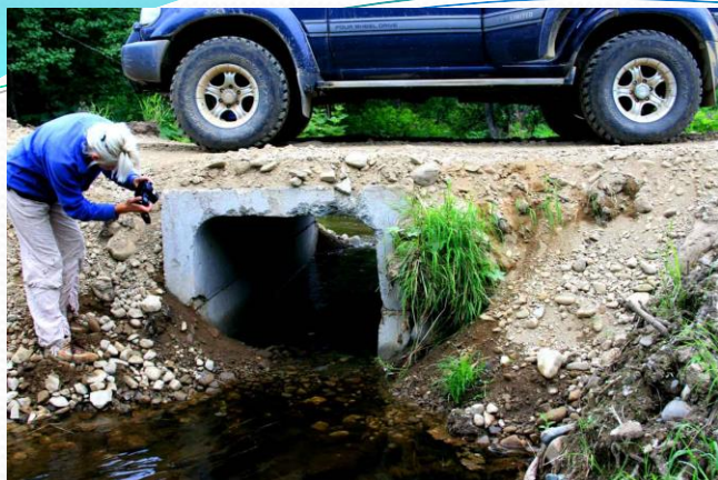
Ручей Б/н. 05.08.09. Вид с правого берега на входное отверстие кульверта. Сползший в ручей грунт заузил живое сечение водотока
