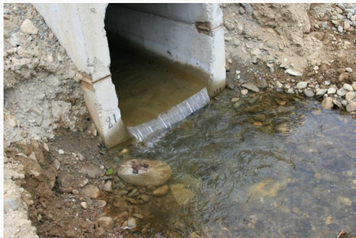
Ручей Б/н. 05.08.09. Вид с правого берега на входное отверстие кульверта. Сползший в ручей грунт заузил живое сечение водотока
