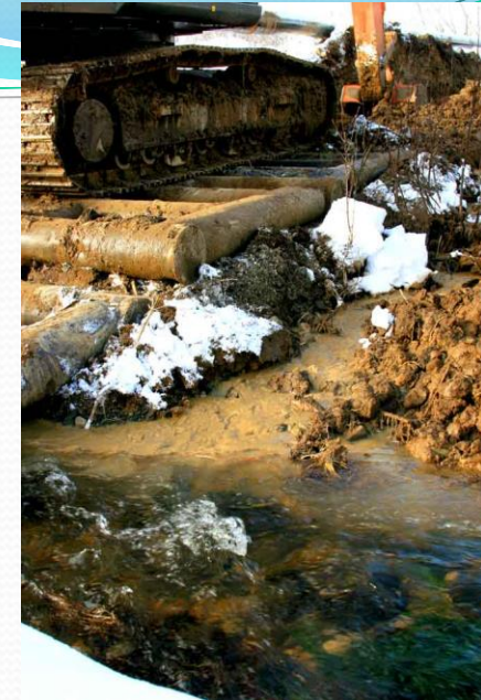
Ручей Симовый. 21.11.08. Строительство траншеи трубопровода, сопровождающееся сбросом сточных вод в ручей с образованием мощного шлейфа мутности
