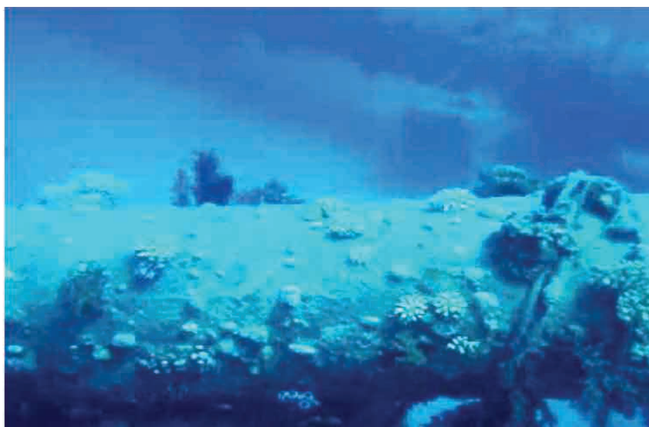
Рис. 2.25. Участок трубопровода спустя несколько лет после укладки на морском дне
