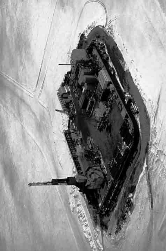
Рис. 1.6. Искусственный остров для добычи нефти у побережья Аляски ( www.oilrig-photos.com )
