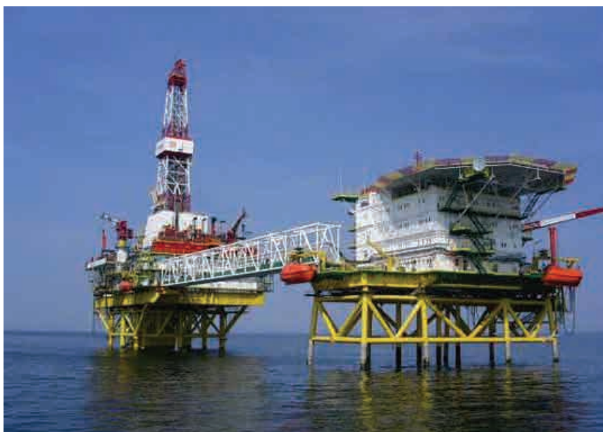
Рис. 1.32. Промысловая стационарная платформа, установленная на месторождении «Кравцовское» (Д-6) в Куршском заливе (23 км от берега, глубина 30 м) ( www.lukoil.ru )
