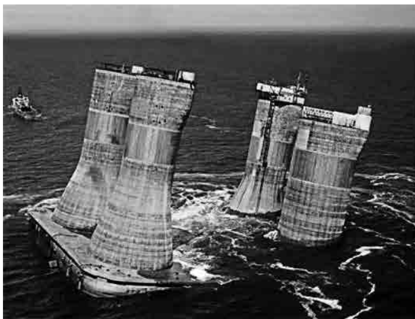
Рис. 1.13. Затапливание железобетонного основания платформы «Лун-А» на северо-восточном шельфе Сахалина на глубине 50 м (июнь 2005 г., проект «Сахалин 1») ( www.sakhalin1.ru )
