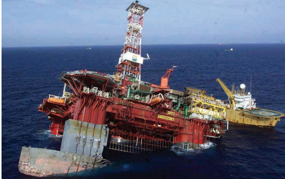
Крушение полупогружной платформы Р-36 в 2001 г. у побережья Бразилии на глубине 130 м ( www.neftianka.ru )
