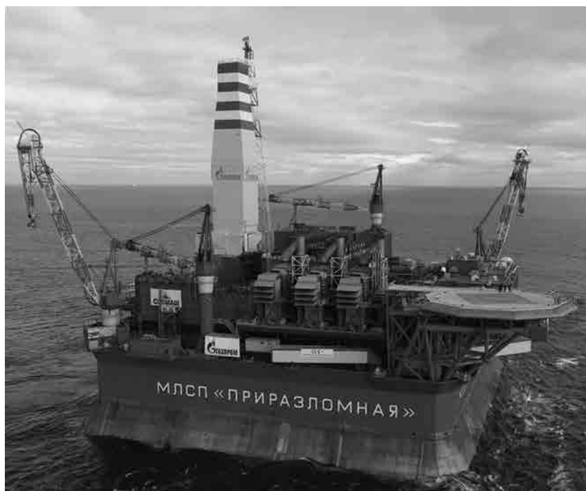
Рис. 1.24. Ледостойкая платформа, установленная на Приразломном нефтяном месторождении в Печорском море ( www.gazprom.ru )
