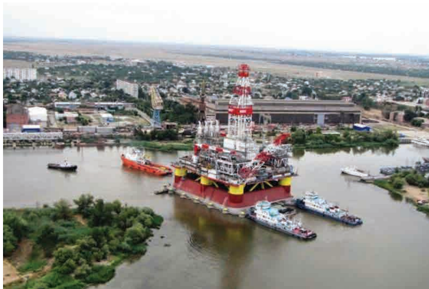
Рис. 1.30. Транспортировка ледостойкой стационарной платформы к месту установки в Северном Каспии (180 км от Астрахани, глубина около 10 м) ( www.lukoil.ru )
