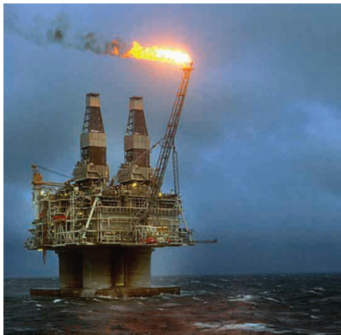
Рис. 1.12. Ледостойкая промысловая платформа «Hibernia» на шельфе Канады (300 км от берегов Ньюфаундленда, глубина 80 м, общий вес 1,2 млн т) ( www.daylife.com )
